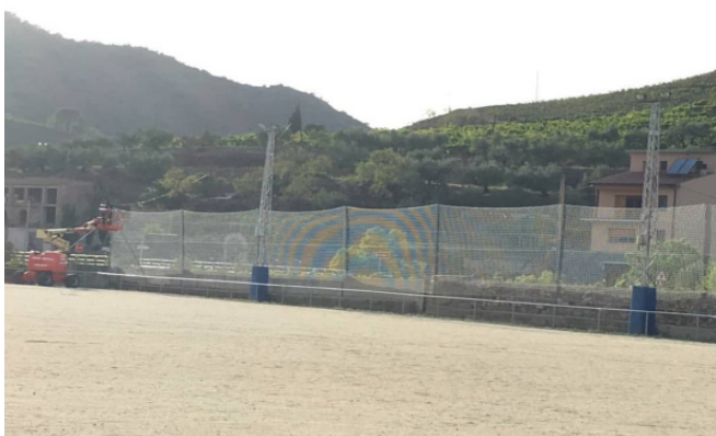
Reparació de les xarxes perimetrals.
