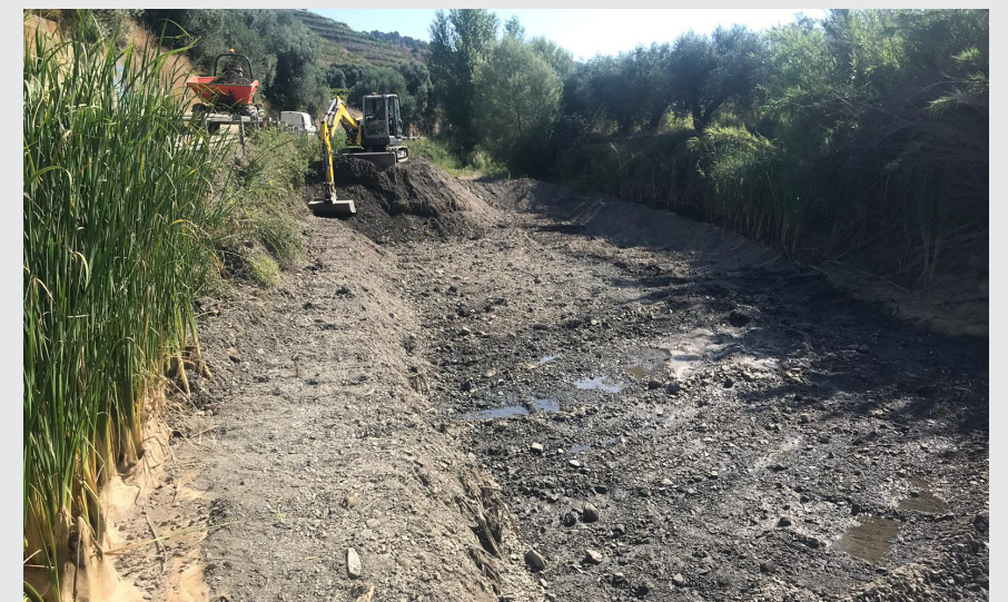
Treballs de retirada dels sediments acumulats a la part alta del pantà.
