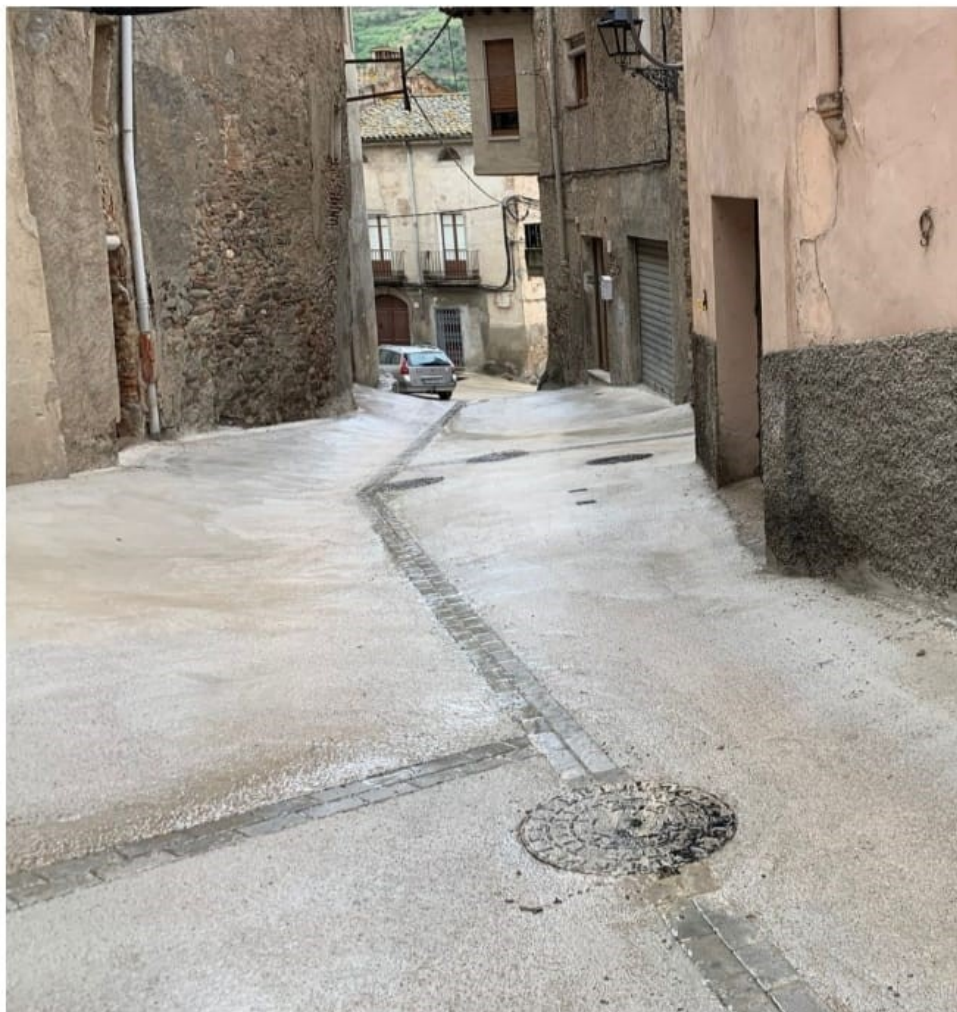
Les obres al carrer de la Peixateria, ja finalitzades.
